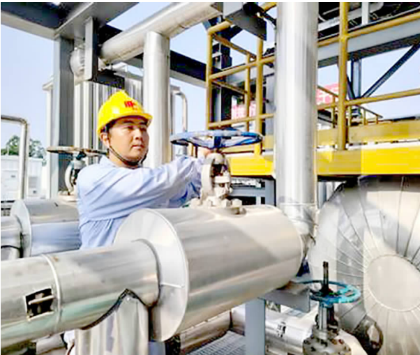
▲ 金石103撬装站根据系统负荷及时调整胺循环流量
